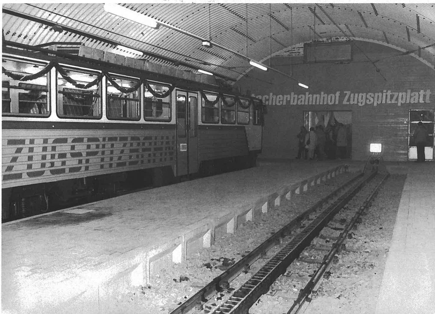
Bayerische Zugspitzbahn: Die Bahnsteighalle des Gletscherbahnhofs Zugspitzplatt, der Endstation der neuen Tunnelzweigstrecke. Links im Bild der gerade in Dienst gestellte Zahnradtriebwagen BeH Nr. 10 als Eröffnungszug.
