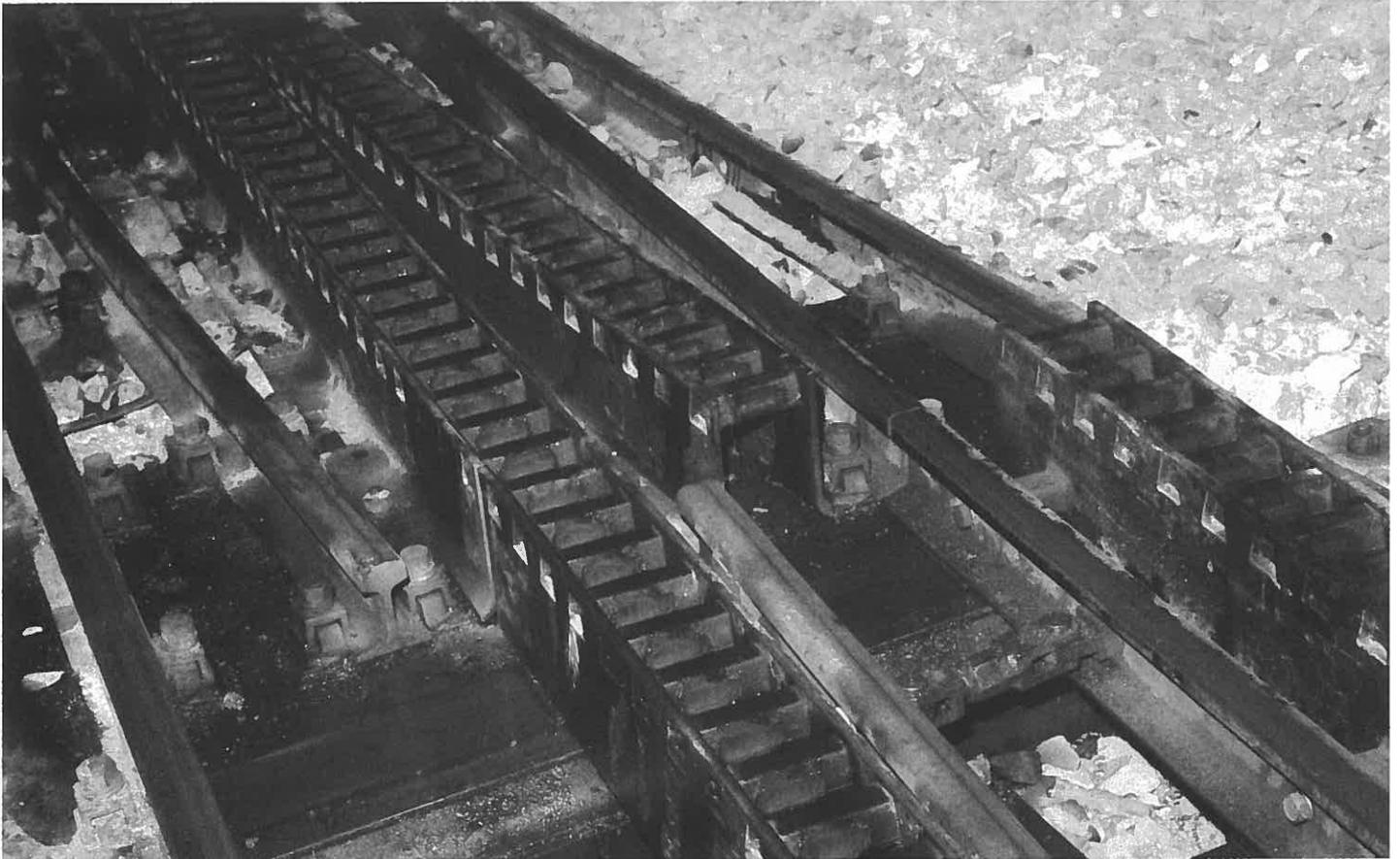
Zahnstangenweiche (System Riggenbach) im Tunnelabzweig zum Gletscherbahnhof Zugspitzplatt der BZB. Das Foto illustriert Teil III von Zeichnung 2.
